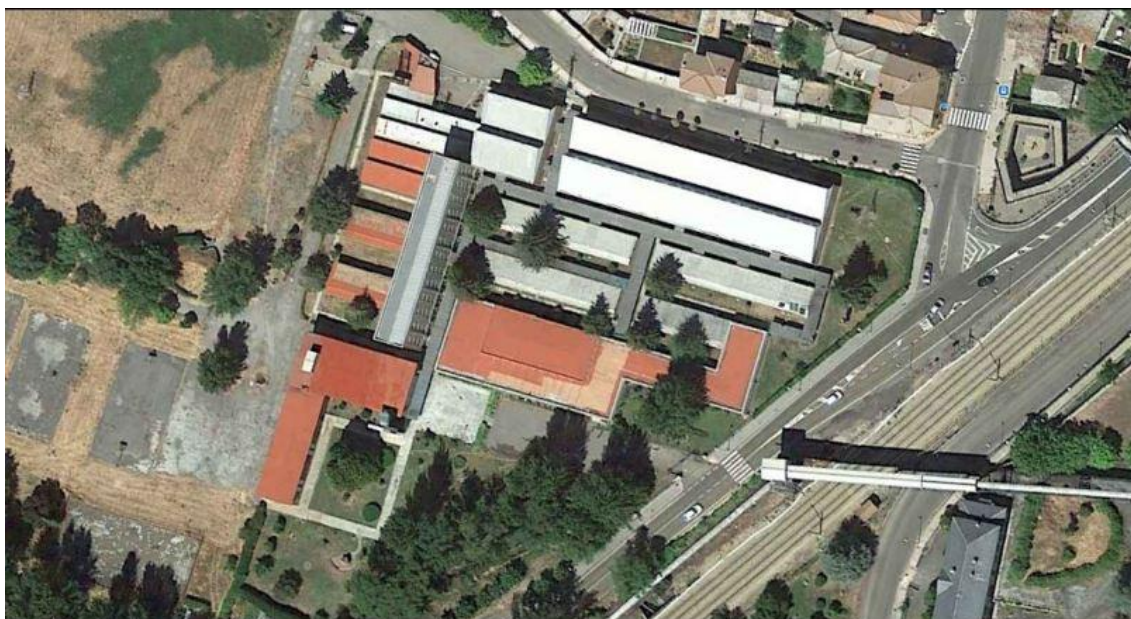
Imagen 1. Vista en Planta del centro en sus edificios, oficinas y administración, aulas y talleres
