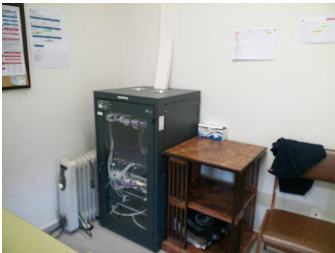
Ilustración 8: RAC con los routers de Escuelas Conectadas
