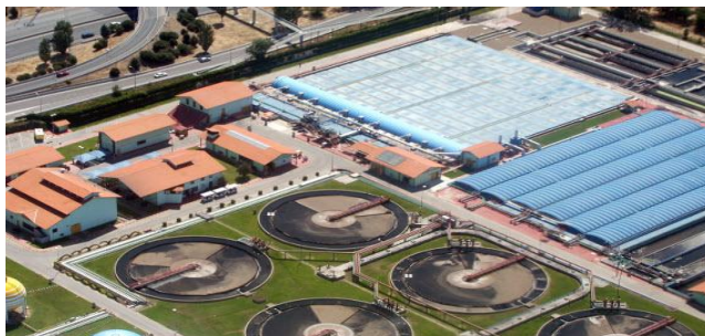
Imagen 12. Depuradora Boadilla del Monte E.D.A.R. http://www.fotosimagenes.org/
