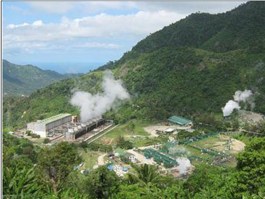
Imagen 15: Central geotérmica. Fuente wikipedia
