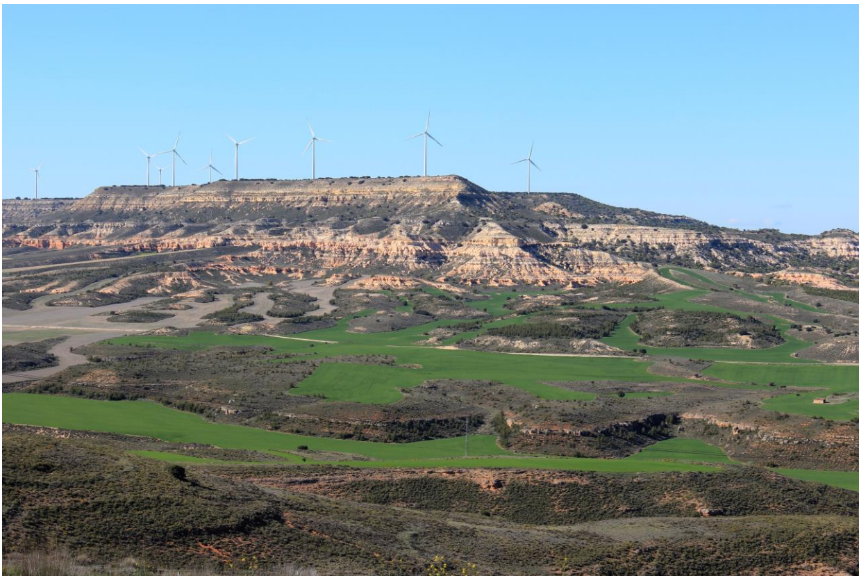
Materiales de la depresión de Almazán dispuestos horizontalmente. Torre Murón 1171 m.
