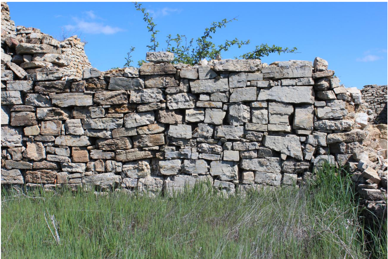
Construcción con calizas de la facies Muschelkalk.
