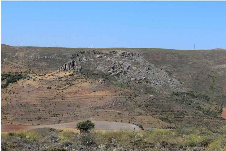
Fig. 8. Desprendimiento en la ladera de la margen izquierda del valle de Arbujuelo.
