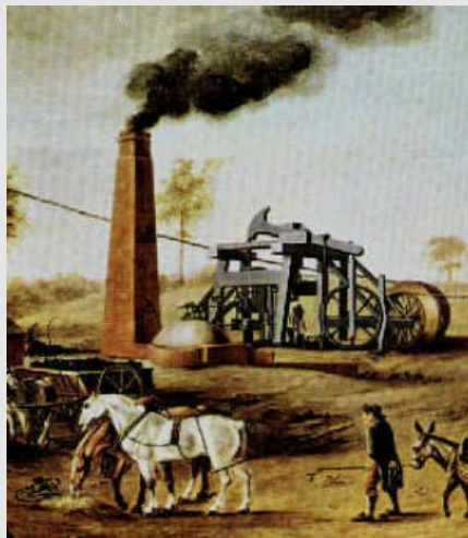
Máquina de Newcomen trabajando en una mina y esquema de dicha máquina.
