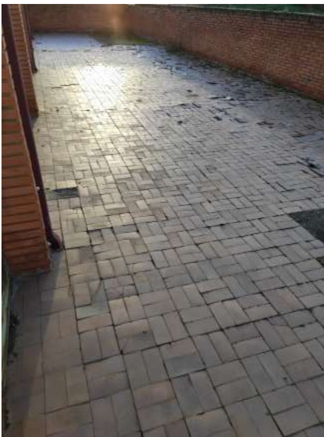
FOTO 7 PATIO DESDE LAS AULAS
