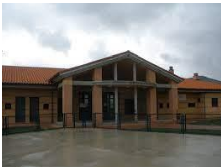
Edificio de Educación Primaria
