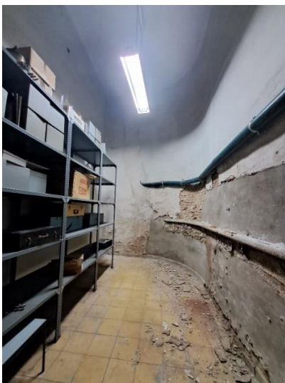
Estado actual zona acometidas
