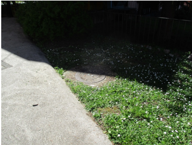
Situación de depósito combustible (1)
