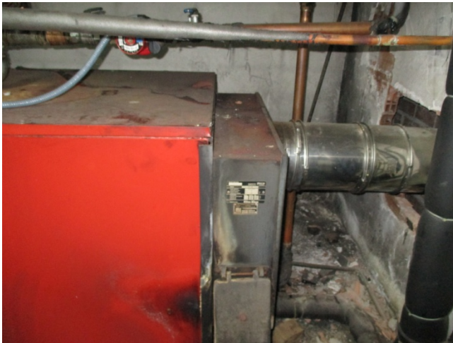
Foto de salida de PDC de caldera
