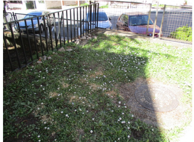
Situación de depósito combustible (1)
