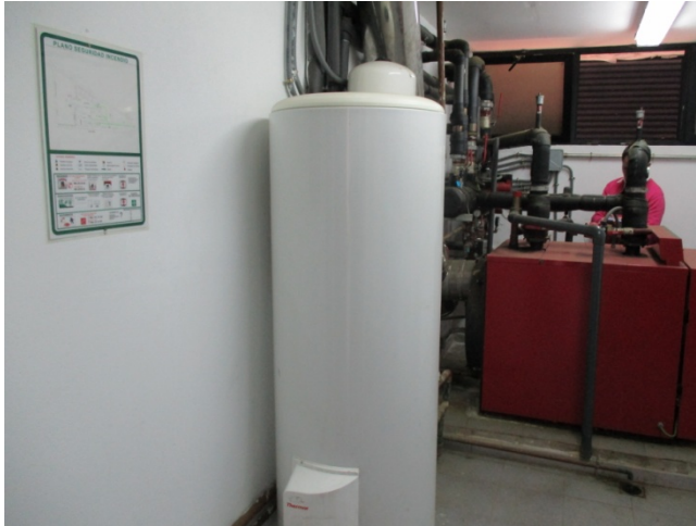
Depósitos de Acumulación ACSo
