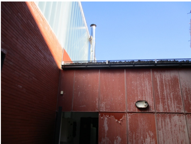
Foto de salida de PDC de caldera
