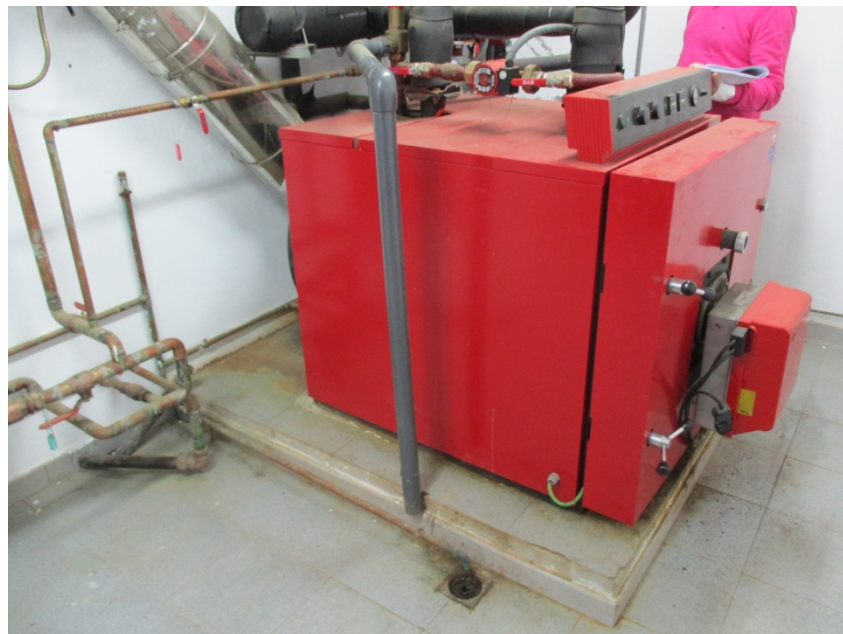
Foto desagüe sala.
