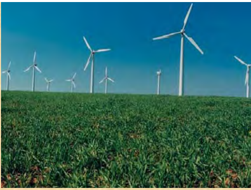
Los parques eólicos están teniendo un importante desarrollo en Castilla y León como fuente de energía alternativa.
